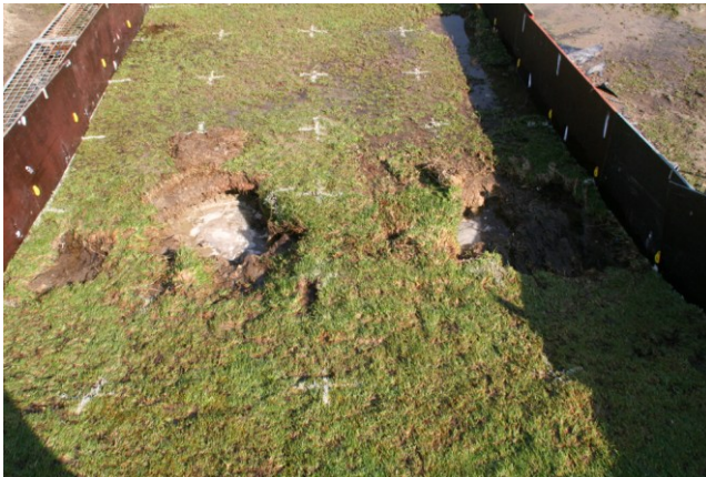
Figuur 3. Proeven op Tholen met de golfverslagsimulator die een 'doorgebroken dijk' weergeven volgens de huidige implementatie van het faalmechanisme.
